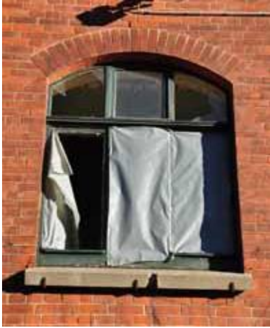
8 Fenster EG Gartenseite
