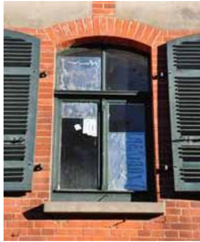
8 Fenster mit Außenjalousien OG
