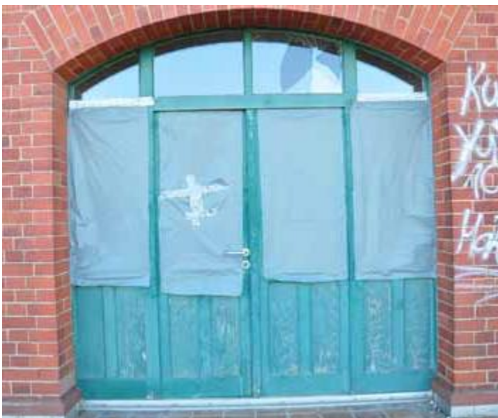
Zugang zum Balkon 1. OG (Tür mit feststehenden Fensterelementen)
