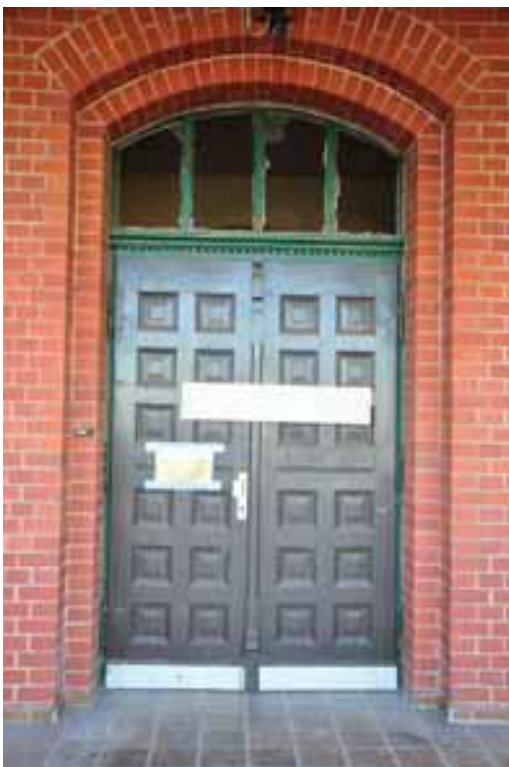
Eingangstür EG getäfelte Tür massiv mit Fensterelement
