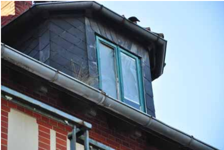
Fenster Dachgauben rechts und links
