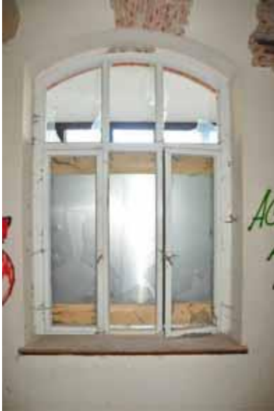
6 Fenster rechts und links der Eingangstür (Aufarbeitung)
