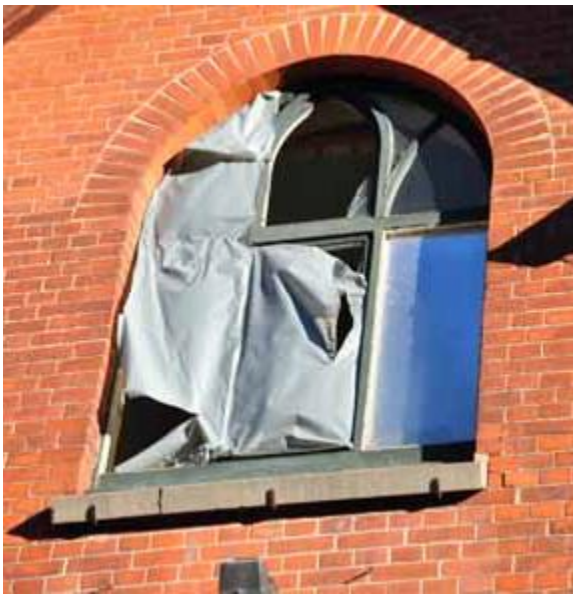
Flurfenster Treppenaufgang zum 1. OG
