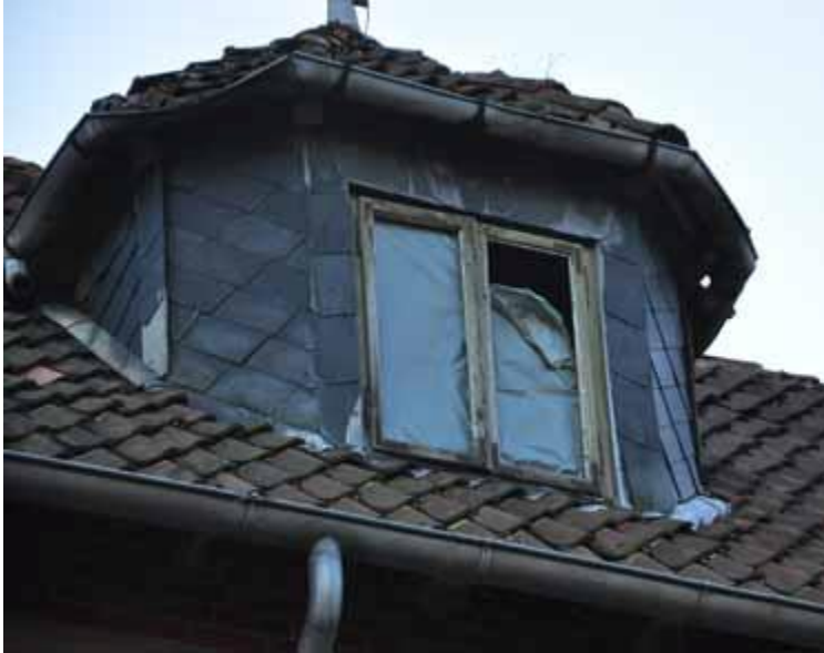
Gaubenfenster im Dachgeschoss
